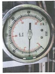
รูปมาตรวัดแรงดันหลังออกจากอุปกรณ์รับลดแรงดัน
