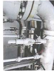
รูปอุปกรณ์ควบคุมความดันก๊าซเชิงกลที่ติดตั้งบนระบบ
